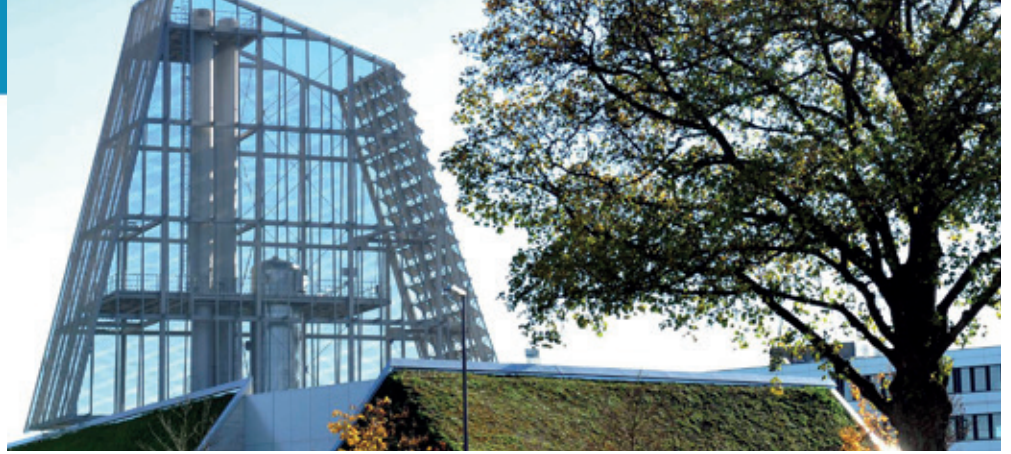
Das Geothermie-Heizwerk der Stadtwerke München liefert ab Herbst erneuerbare Fernwärme für Freiham und angrenzende Stadtteile
